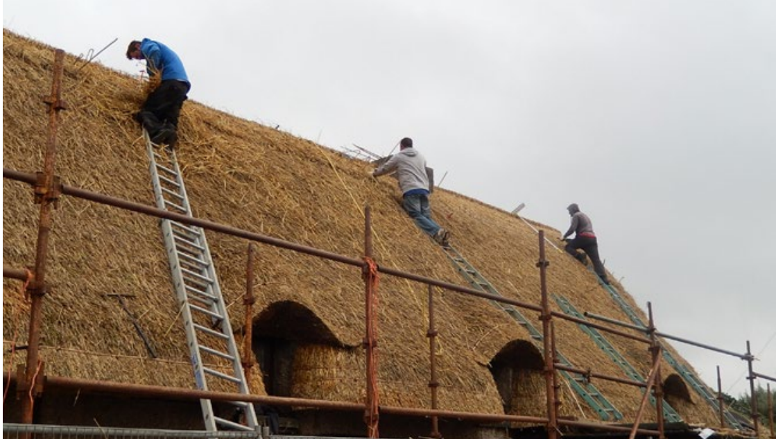
Deisiú deontais ar dhíon tuí ar Sheanteach Choill na Sceiche, an Ros
